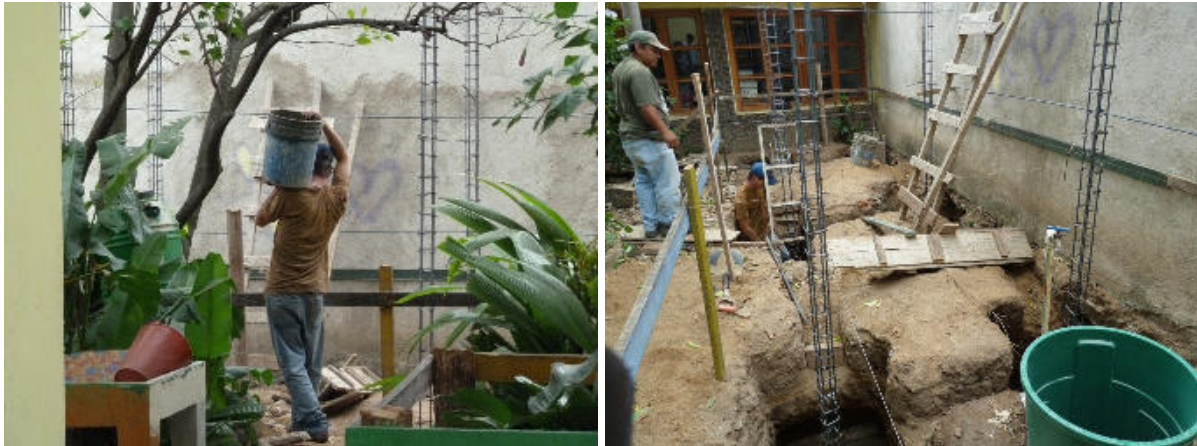
Bauarbeiten am Bad
