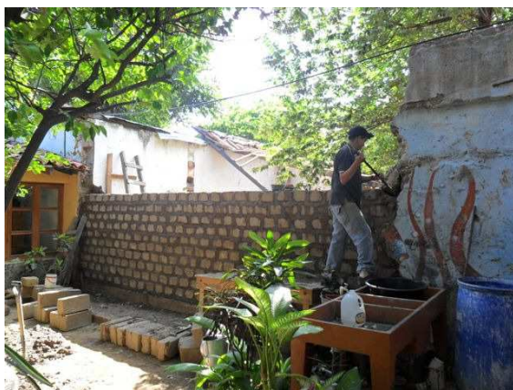
Arbeit an der Bibliotheksmauer
