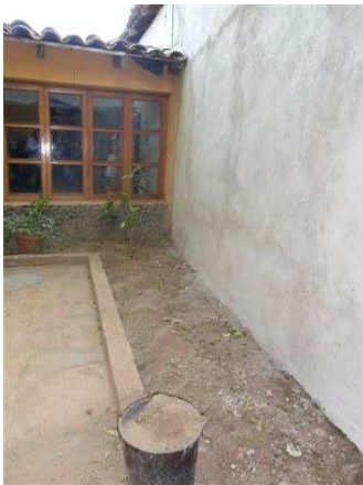
Fertig verputzte Mauer!
