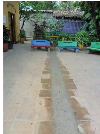
Auf dieser Strecke wurde ein Rohr ausgetauscht!
