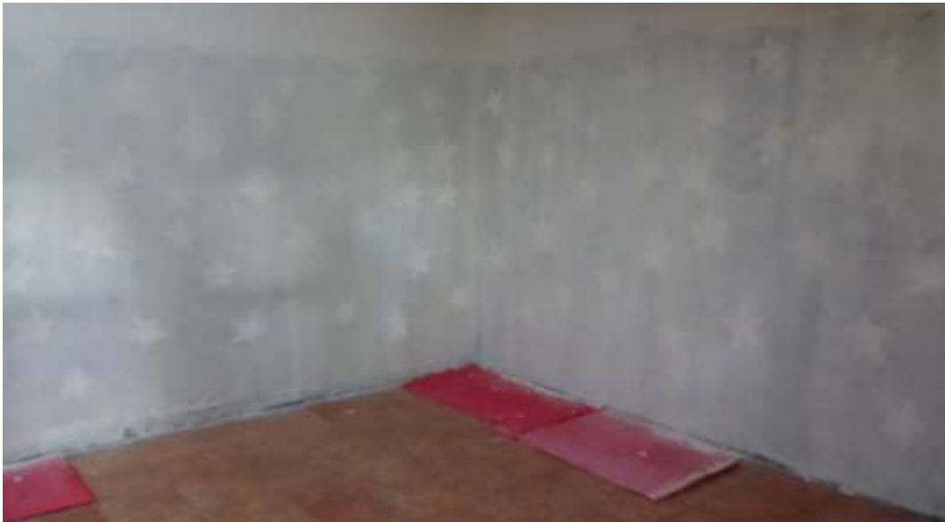
Die „esquina de lectura“ nach dem ersten weißen Anstrich, insgesamt mussten wir vier mal weiß drüber streichen, bis es ebenmäßig war
